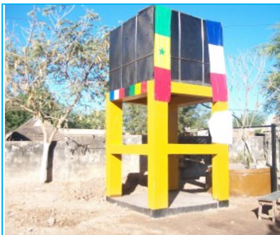
Fig. 3 : Château d'eau de l'école Sada Maka Sy
